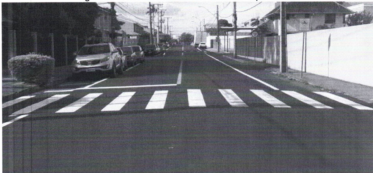
Figura 10 – Faixa de Travessia de Pedestres – Tipo Zebrada
