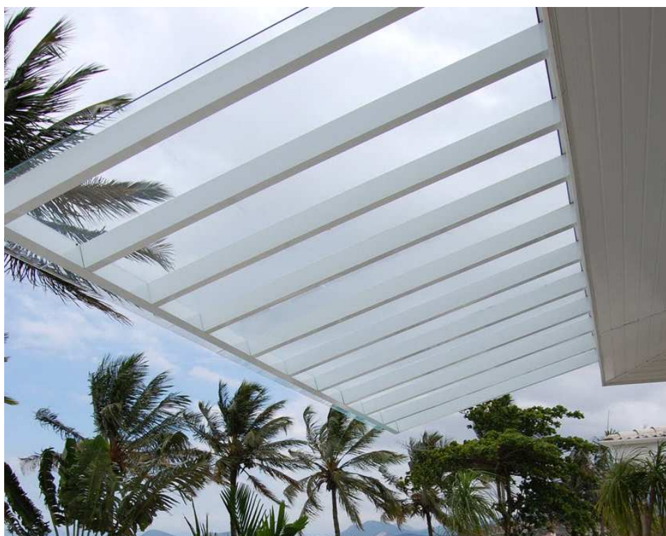
Imagem 07 – Modelo de toldo em alumínio, revestido com polycarbonato
