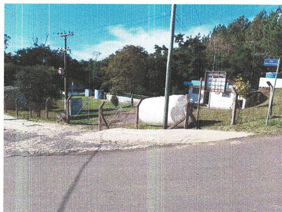
ETA (Estação de Tratamento de Água)
