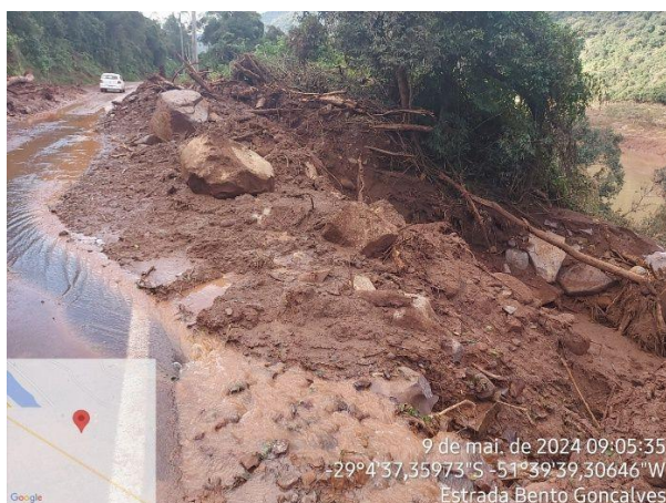
Foto 3: Deslizamentos na Estrada Bento Gonçalves em 2024 – 03/03
