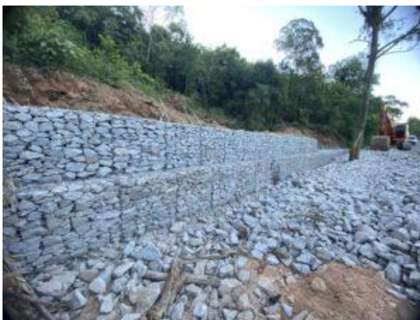
Figura 4 – Exemplo de solução executada de muro de gabião
